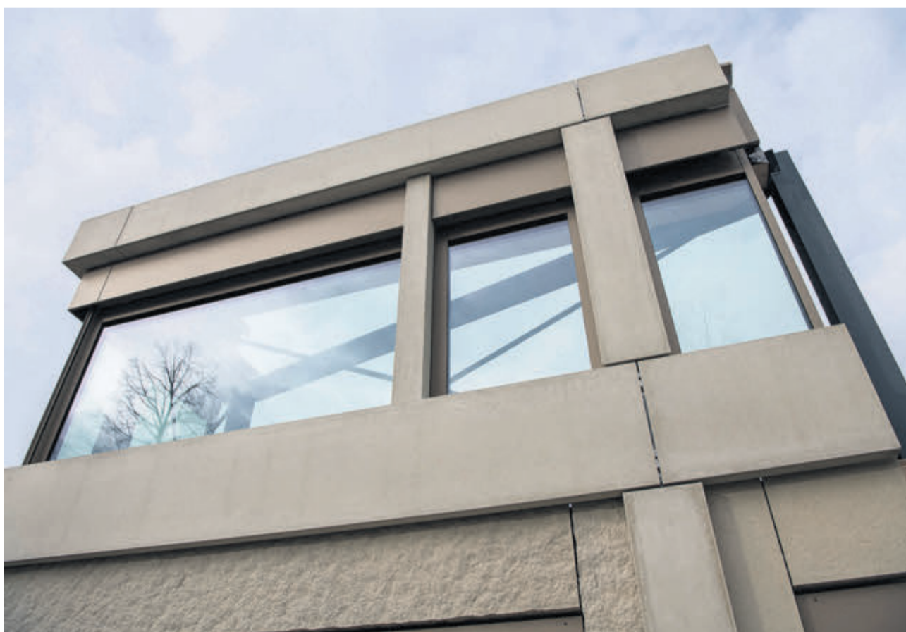
Blick auf ein Obergeschoss: Zwischen den isolierten Metallfenstern befinden sich eine kleinere Nebenlisenen (links) sowie die Hauptlisenen. Während Farben und Materialisierung den Plänen entsprechen, sind Dimensionen und Proportionen des Mock-ups nicht realitätsgetreu ausgeführt.
