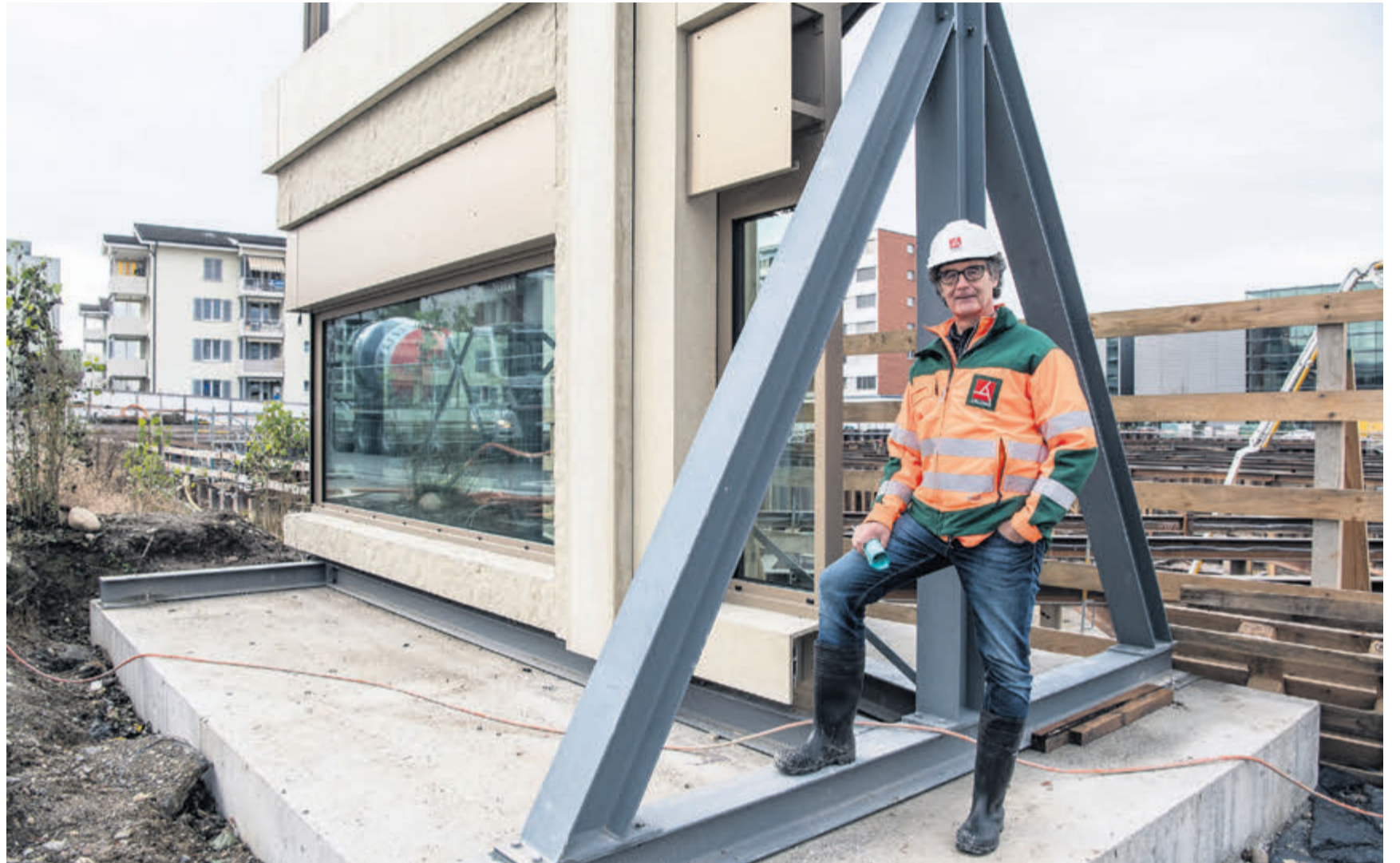
Bauleiter Thomas Stalder von der Anliker AG Generalunternehmung neben der Mock-up-Wand. Diese ist in Absprache mit der Stadt Sursee rund zwei Meter breit, 5,5 Meter lang und mehr als 6 Meter hoch geworden. Sie wird nach den Detailabklärungen in einigen Monaten wieder abgebaut und fachgerecht entsorgt. FOTOS FABIAN ZUMBÜHL
